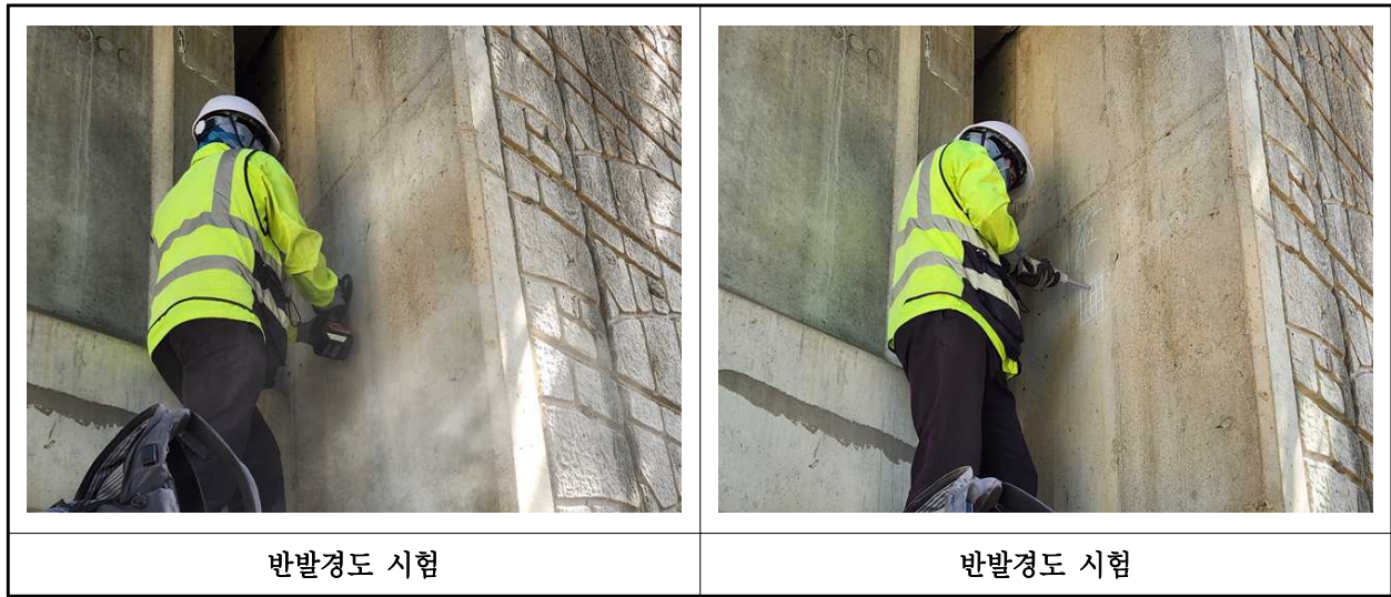
【사진 4.4.2】 반발경도시험 현장사진
