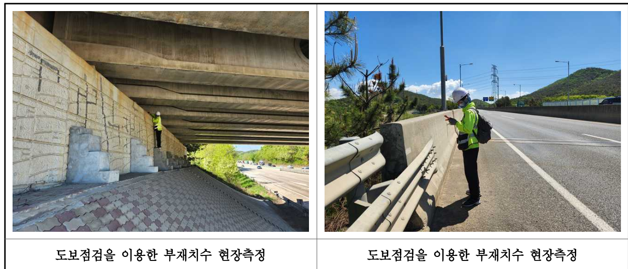
【사진 4.2.2】 부재 현장측정 전경
