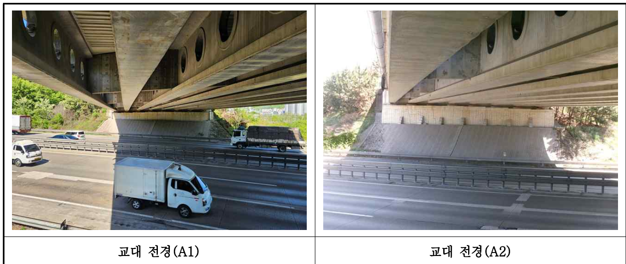
【사진 4.3.8】 교대 전경
