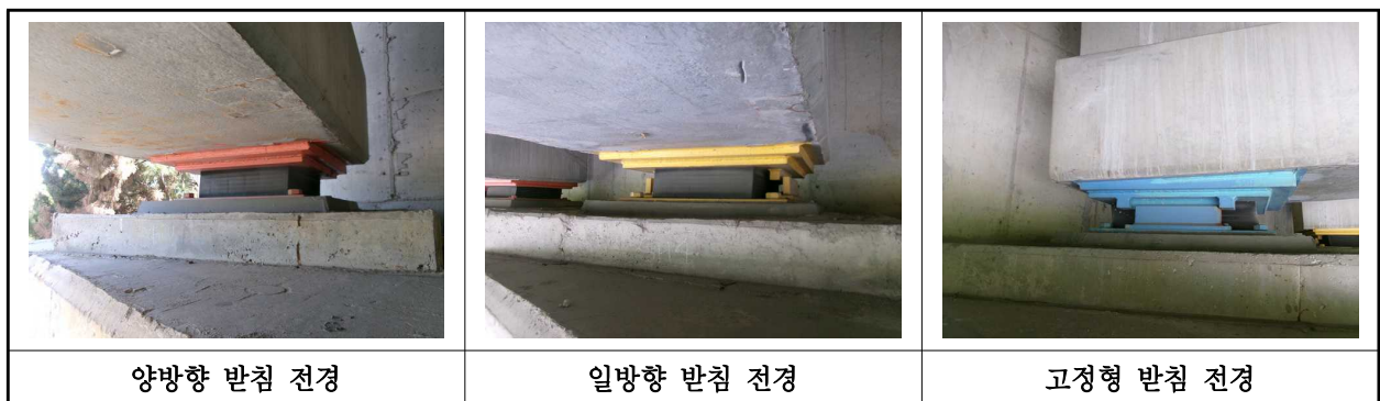
【사진 4.3.12】 교량받침 전경
