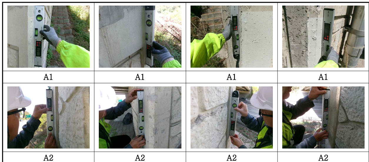
【사진 3.3.10】 교대 기울음 측정 현황
