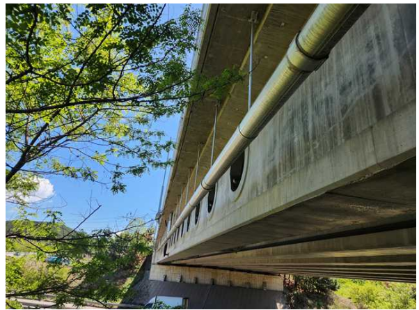
바닥판하면 S1 외측 캔틸레버 상태현황
