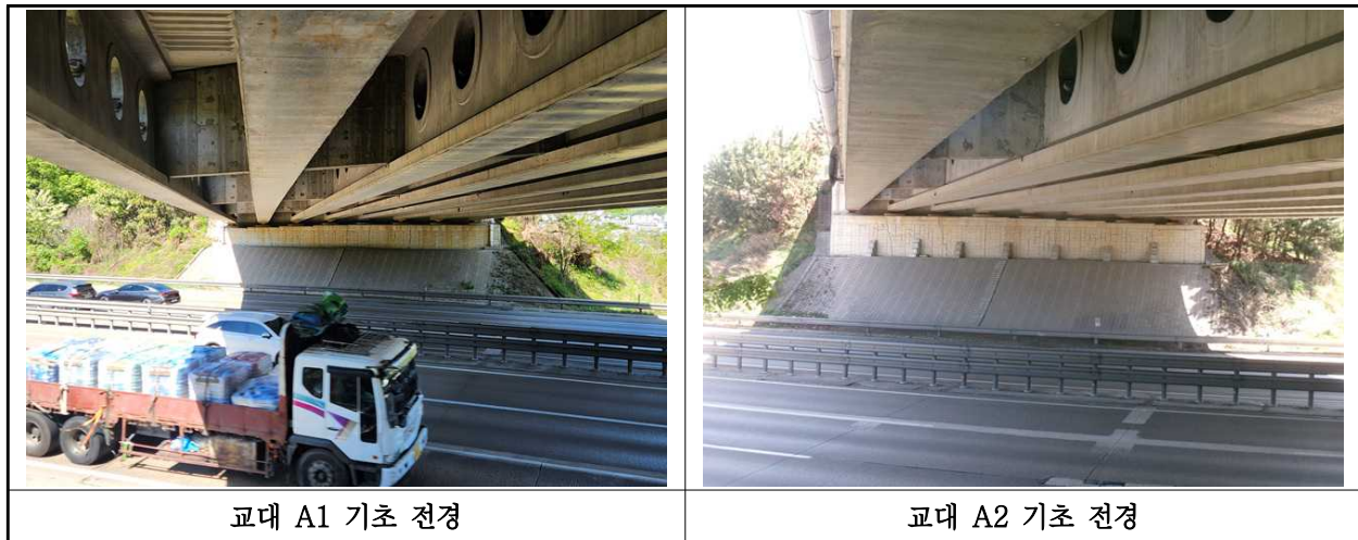
【사진 4.3.11】 기초 전경
