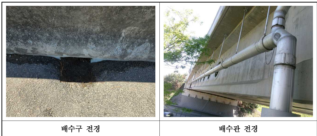
【사진 4.3.21】 배수시설 전경
