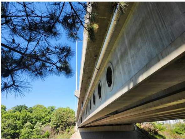
바닥판하면 S1 외측 캔틸레버 상태현황
