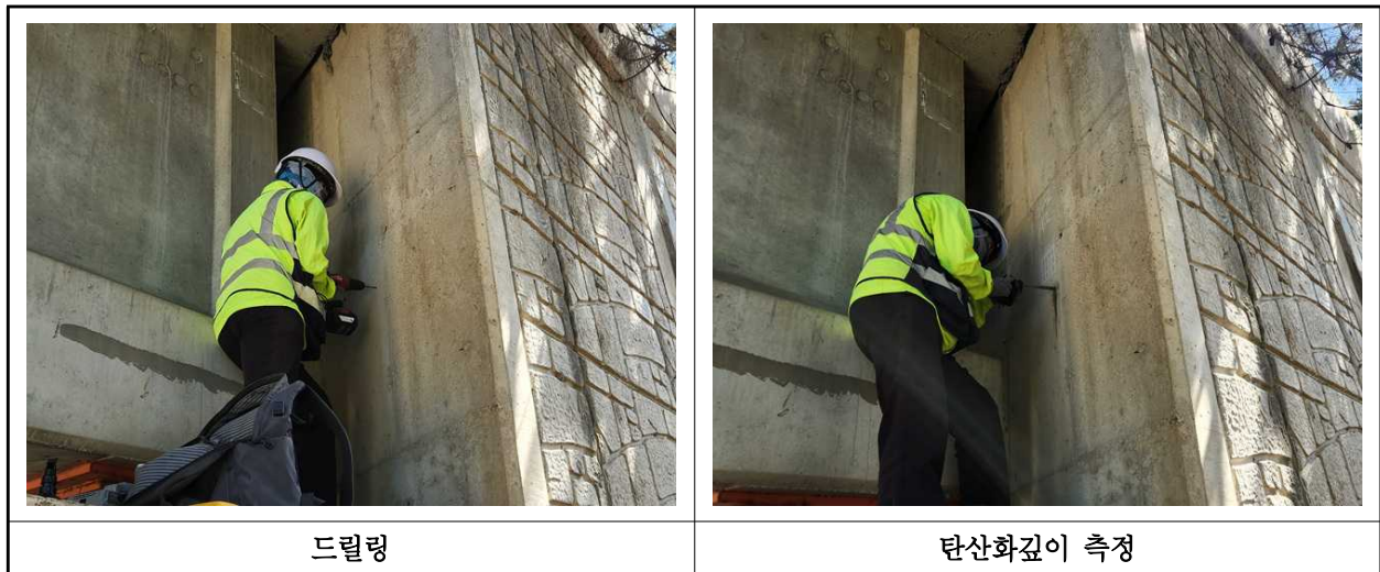
【사진 4.4.3】 탄산화 깊이 측정 현장사진
