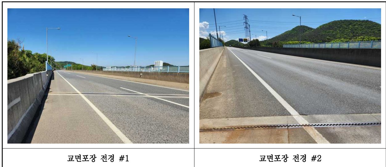
【사진 4.3.19】 교면포장 전경
