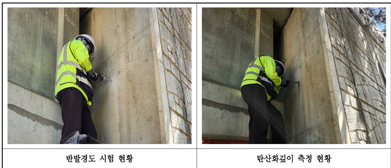
【사진 4.4.1】 콘크리트 내구성조사 현황
