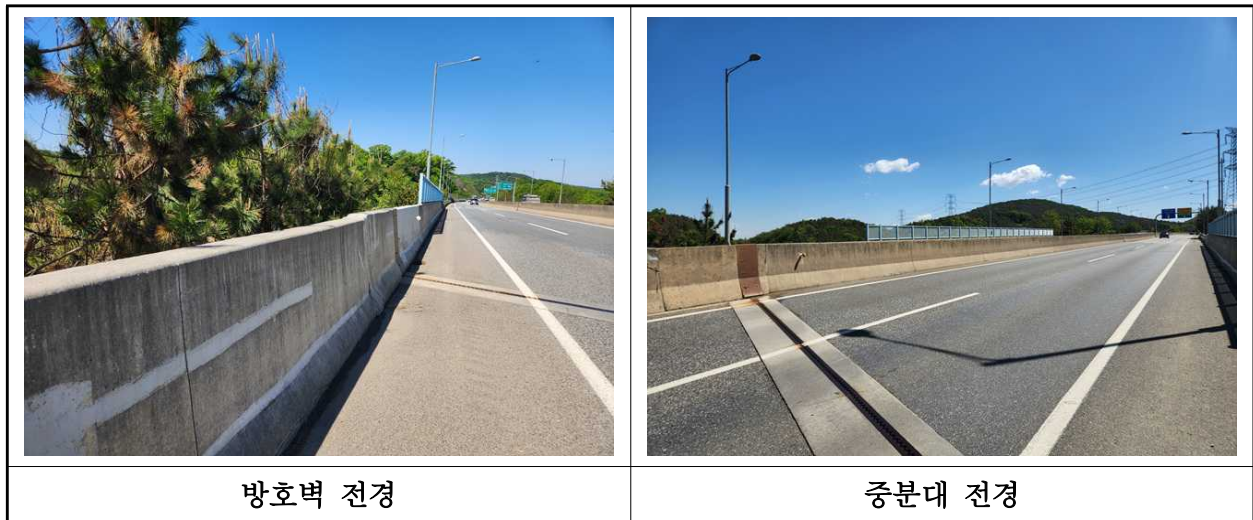
【사진 4.3.23】 방호벽 및 중분대 전경
