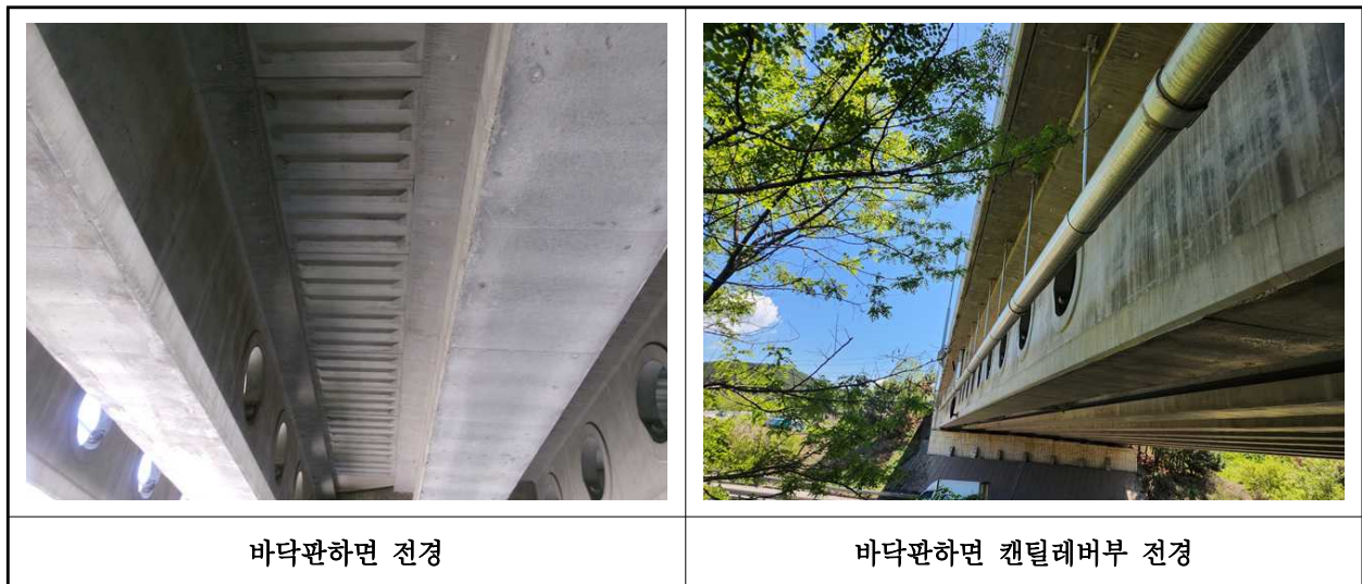
【사진 4.3.2】 바닥판하면 전경
